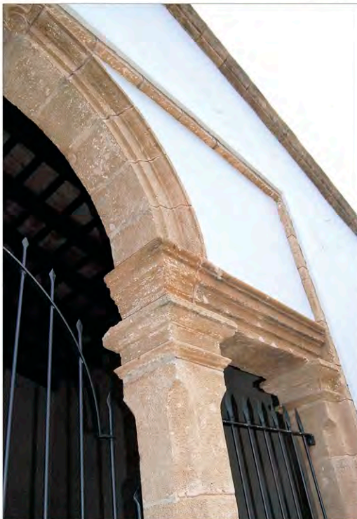
Detalle del pórtico serliano.
